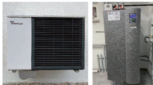
Installationsbeispiel: Luftwärmepumpe Außengerät wandhängend mit Hydraulikstation inkl. WW Speicher
